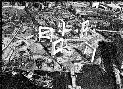
ループ部の 橋脚が完成
